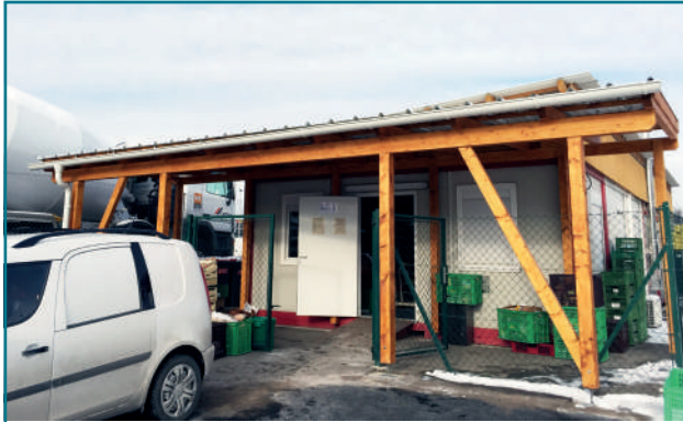
Ein neues Dach für den SOMA Klosterneuburg
