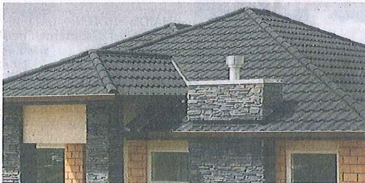
**Ein Gerard Dach ist ungefähr sieben Mal leichter als traditionelle Ton- oder Betondächer, außerdem sicherer und widerstandsfähiger.** Foto: zVg
